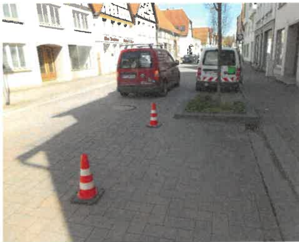
Bild 2: geprüfte Pflasterdecke, Mittlere Str. 49, 32676 Lügde
